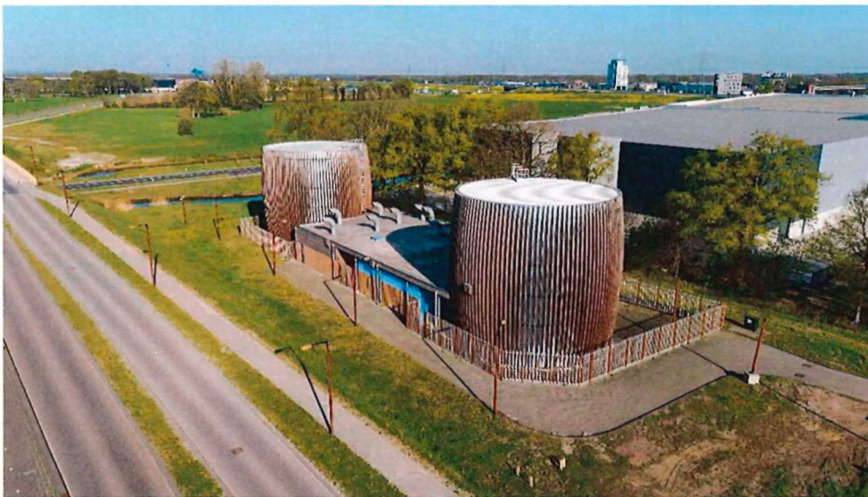
Figuur 4: foto van de centrale blusvoorziening
